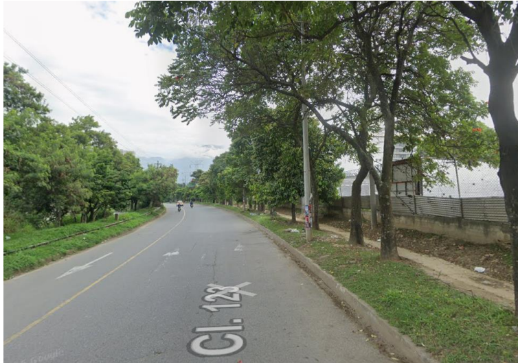
Figura 9 VT del Sistema Vial del Río a la altura de la calle 123
